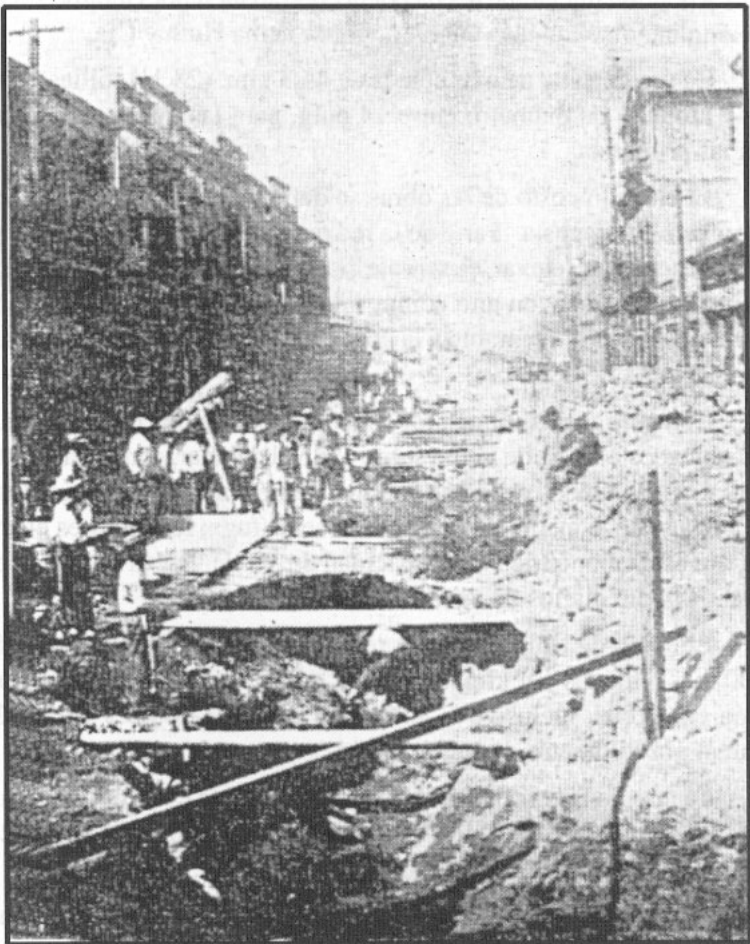
Iniciación de los trabajos de alcantarillado en la calle Washington, 1905.
