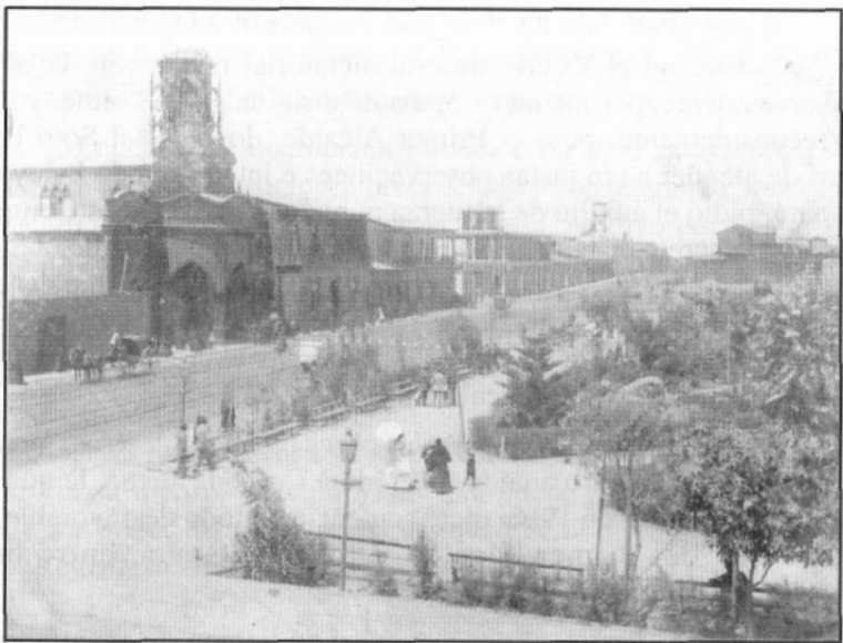
Iglesia de Antofagasta destruida por otro incendio.
