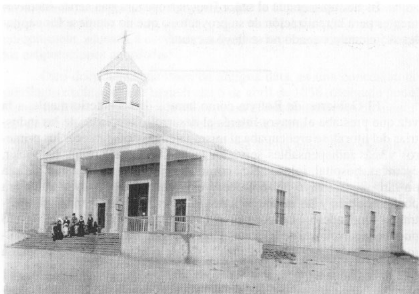
Templo parroquial de Cobija, construido después del terremoto de 1877.
